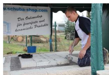
**Schritt 3:** Als zweite Schicht werden die Speicherplatten - Schamotteplatte Schuba®FFP-A35t, 625x500x64 mm, P2-64 (im Bausatz!) aufgesetzt. Dazu zuerst die Position der Speicherplatten anzeichnen. Diese dann ebenfalls vollflächig mit dem Schamottemörtel einstreichen und entsprechend positionieren. Die Stoßfuge ebenfalls mit vermörteln!
