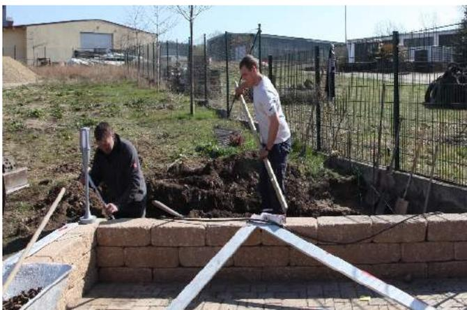
**Schritt 1:** Für das Fundament ein genügend großes Loch / Graben ausheben. Für den Bausatz SBO-1 bei Plattenfundament: ca. 1,40 m breit, 2,00 m lang und 1,10 m tief. Bei einem Streifenfundament hebt man einen Graben von ca. 0,2 m Spatenreite aus. Die Tiefe ist entscheidend für den Frostschutz, bei durchlässigem Boden reicht der Aushub mit 0,40 – 0,50 m.
