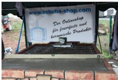
**Schritt 10:** Die Schüttung wird mit Ölpapier Schuba®OEP-80 (im Bausatz!) abgedeckt, um danach Beton zum Verschließen des Feuerfestkerns aufzubringen. Im ersten Schritt wird der grob verteilt. Wir bringen zur Stabilität Baustahl als Armierung ein und ziehen danach den Beton glatt.
