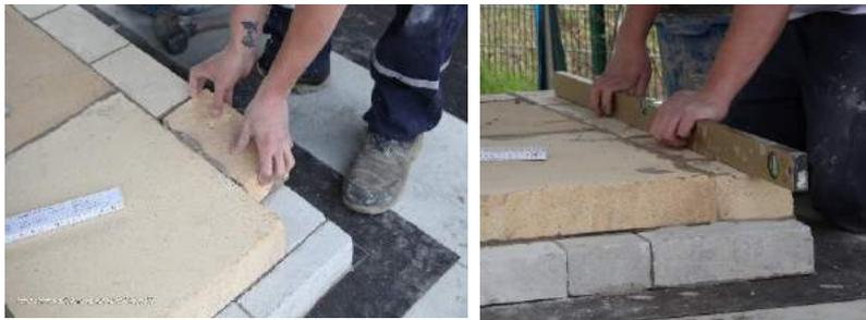
**Schritt 5:** Die Ummauerung wird nun im Verband fortgesetzt, d. h. die Stoßfugen sind um einen halben Stein versetzt. Sollten Mörtelreste an den Steinen entstehen - vor allem die im Backraum - gleich entfernen am besten mit einem feuchten Schwamm.
