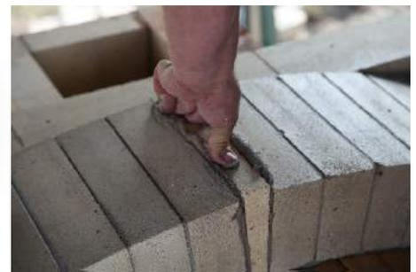
Die Stütze kann gleich nach dem Schließen des ersten Gewölbebogens entfernt und versetzt werden. Das Gleiche gilt für den zweiten und den dritten Gewölbebogen. Beim Einsetzen der Stütze jedes Mal gut nachmessen um diese richtig auszurichten. Nur so kann eine gleichmäßige Kuppel aufgebaut werden. Am Ende des Gewölbeaufbaus kann die Stütze entnommen werden.
