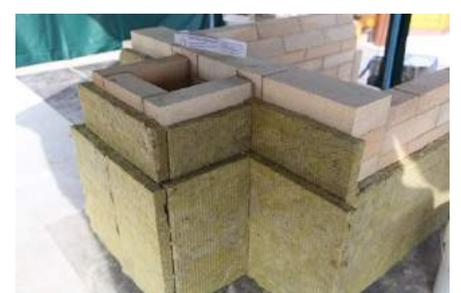
**Schritt 2:** Jetzt werden die weichen Isolierplatten Schuba®ISP-MIN75-10, 1200x600x30 mm (im Bausatz!) rund herum doppellagig mit Isolierplattenkleber Schuba®KB-KM (im Bausatz!) auf die Außenwände geklebt. Die Platten lassen sich problemlos mit einem einfachen Cuttermesser / Teppichmesser zuschneiden. Der Kleber wird punktuell aufgetragen und für beide Schichten verwendet.
