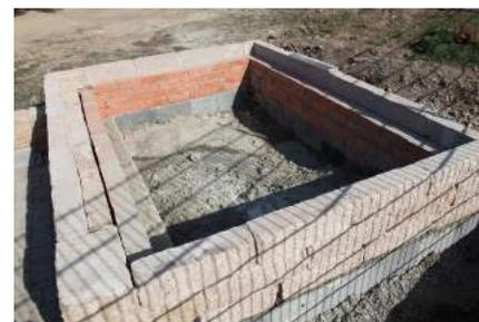
**Schritt 7:** Zur Angleichung der Höhe haben wir für unseren Sockel weitere Steinreihen aus Schalungssteinen auf das Streifenfundament aufgebracht. Die Fläche wurde dann mit Kies und Schotter aufgefüllt und so zum Ausgießen der Platte vorbereitet. Zum Verblenden haben wir Ziersteine verwendet. Diese wurden mit Spanngurten fixiert um die Stabilität – auch für das Auffüllen mit Beton – zu gewährleisten.
