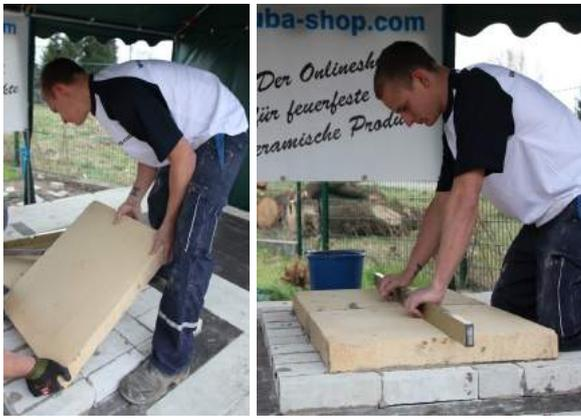
Hier ist Kraft gefragt: Die Speicherplatten sind schwer und helfende Hände sind willkommen! Nach dem Zusammensetzen der Platten, sofort ausrichten und ggf. die Position korrigieren.
