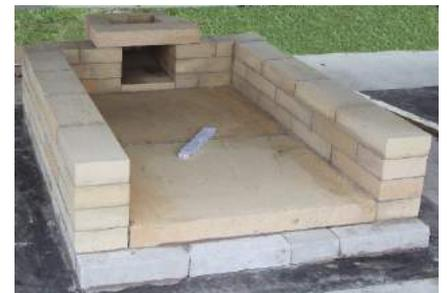
**Schritt 7:** Die seitliche Mauerkrone (Widerlager) bildet den Anschluss des Gewölbes. Hierzu sind 67°-Winkelschnitte bei den Schamottesteinen (NF2) erforderlich. Die Winkelschnitte mit Hilfe von Winkelmessern anzeichnen, um dann die notwendigen senkrechten Schnitte sauber durchzuführen. Sind die Steine vermauert steht der Feuerfestkern ohne Gewölbe.
