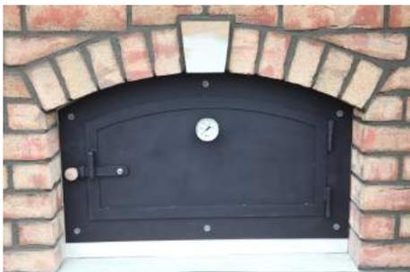
Jetzt kann die Tür eingesetzt werden. Unsere Backofentür Schuba®BOT-1 (linker oder rechter Anschlag) bekommt man fertig lackiert mit einer Flasche Einbrennlack, um diesen noch einmal frisch aufzutragen. Der Lack wird erst beim Hochheizen fest bzw. richtig eingebrannt. Die Ankerschrauben zur Befestigung bekommt man mitgeliefert. Die Türen haben einen Einschub für ein Backofenthermometer Schuba®BT-0231 (Zusatzprodukt) vorgesehen.
