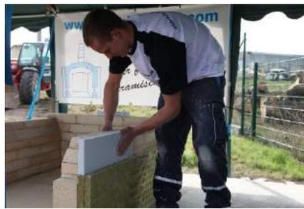
**Schritt 3:** Im oberen Drittel werden die druckfesten Isolierplatten Schuba®ISP-C1000, 625x500x30 mm (im Bausatz!) - ebenfalls doppellagig - aufgeklebt. Diese werden vollflächig mit dem Isolierplattenkleber eingestrichen. Der Zuschnitt kann auch problemlos mit der Isoliersteinsäge erfolgen.
