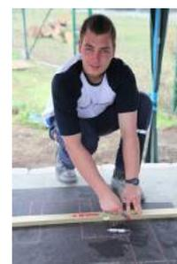
**Schritt 1:** Als erstes wird die Grundfläche gemäß den Maßen des Bauplans auf das Fundament aufgezeichnet. (Wenn die Betonfläche zu stark sandet ggf. vorher grundieren) Entsprechend wird die Form aus einer Sperrlage (wir empfehlen einen Bitumenschweißbahn) zugeschnitten und aufgelegt. Darauf werden die verschiedenen Schichten mit einem Edding aufgezeichnet.
