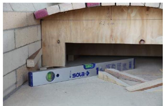
Für die Kuppel werden die Schamottewölber Schuba®FFW-A35t, 250x124x67/61 mm, 2H6 (im Bausatz!) benutzt. Wichtig: die Steine von beiden Seiten aus einsetzen, so dass nur für die Mitte der letzte Stein zugeschnitten werden muss. Zum Aufbau wird der Schamottemörtel verwendet. Der zugeschnittene Mittelstein wird vollflächig eingestrichen und eingesetzt.
