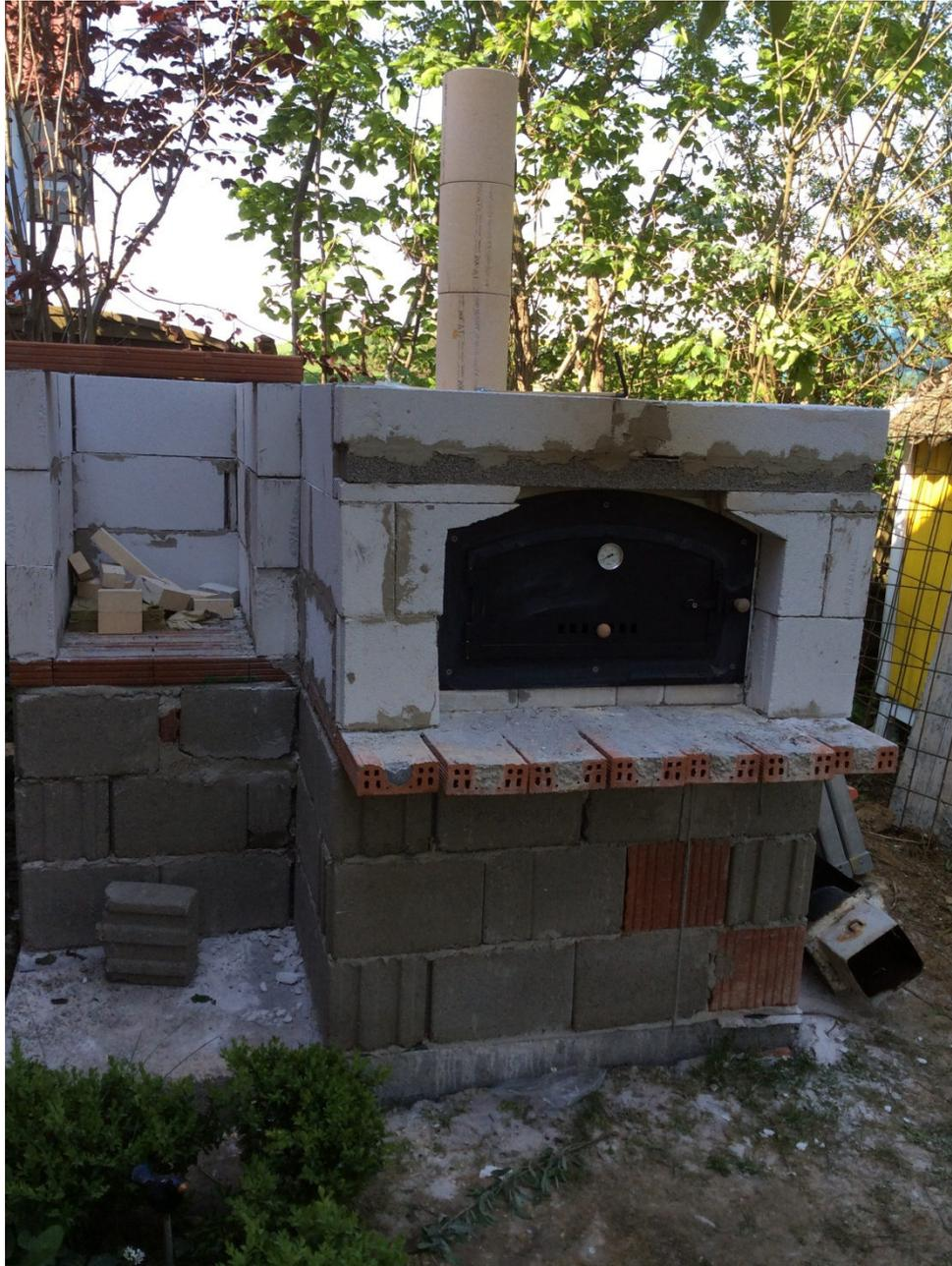
Sieht gut aus, also Ringanker betonieren und Dachstuhl aufbauen.
